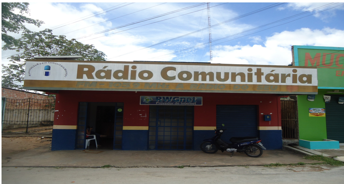
Fachada da Sede da Rádio Comunitária Mucajaí (RR)
